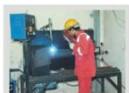
CO 2 Mig Welding
